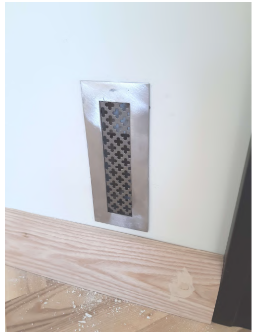
2 pav. Parketo ventiliacijos grotelės
